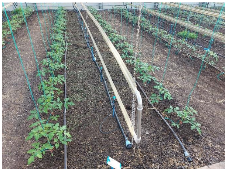
Bild 2: Tomatenbeet nach Pflanzung mit abgesenkter Vegetationsheizung
