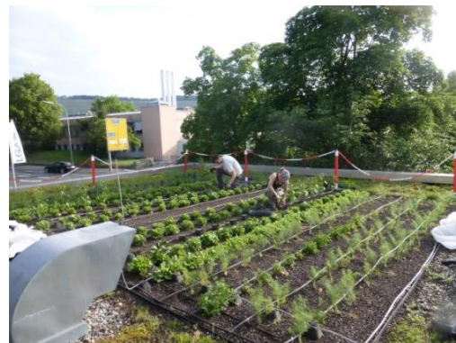
Bild 2: Abgeräumtes Versuchsdach bei der LGA mit Einrandung für Versuchsfläche
