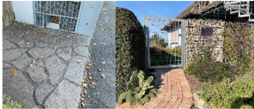
Bild 14 (links): Blechrahmen als Durchschlupf in einer Pergone: Was für die geliebte Katze ermöglicht wurde, hilft auch dem Igel. Bild 15 (rechts): Alles richtig gemacht: Pergonen-Stabmatten-Kombination mit rund 10 cm lichter Höhe unter dem Gartentorrahmen.
