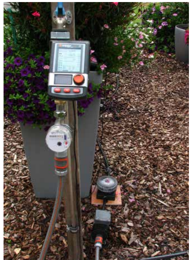
Bewässerungscomputer in Kombination mit Wasseruhr
