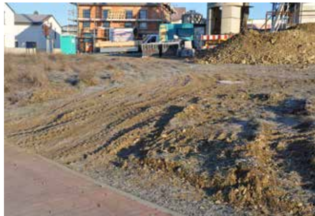
Baustelle im Hausgarten
