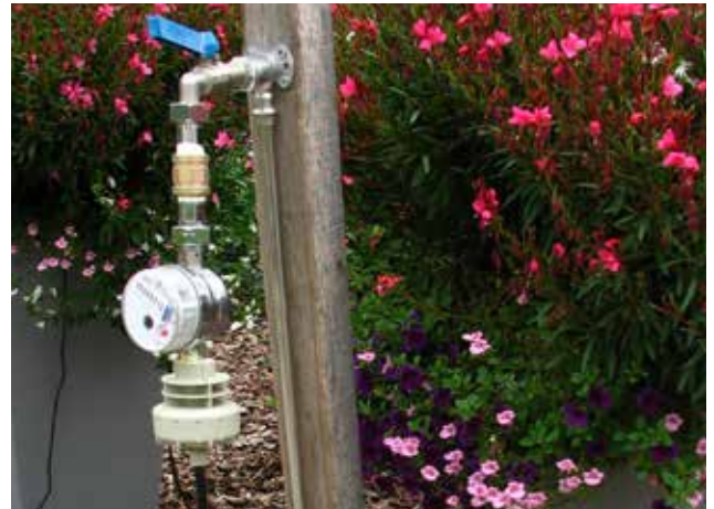
Tropf-Blumat: Wasseruhr, Druckminderer mit Filter
