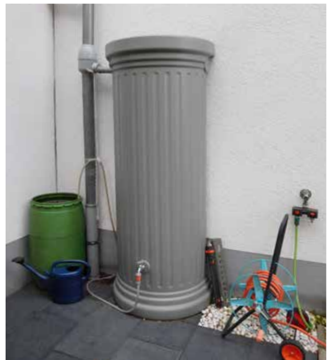
Moderne Regenwasserzisterne - oberirdisch
