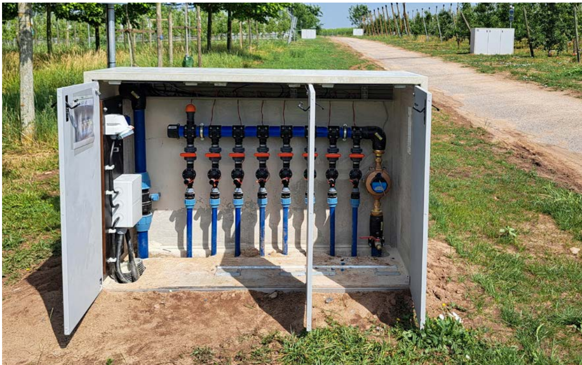
Eine von 20 Verteilerboxen mit je acht ansteuerbaren Bewässerungssträngen.
