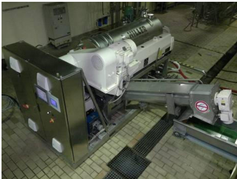
Abb. 6: Dekanter vom Typ DecaFood, Hiller GmbH, in einem Fruchtsaftbetrieb (Aufnahme: HILLER GmbH, Vilsbiburg)
