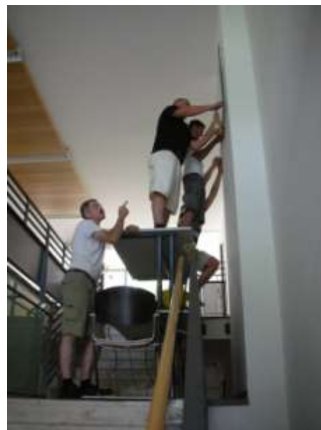
Mit dem Ratschlag des Hausmeisters kann nichts mehr schief gehen.
