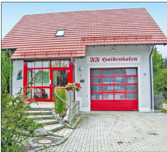
Das Feuerwehrhaus errichteten die Dorfbewohner ganz in Eigenleistung.
