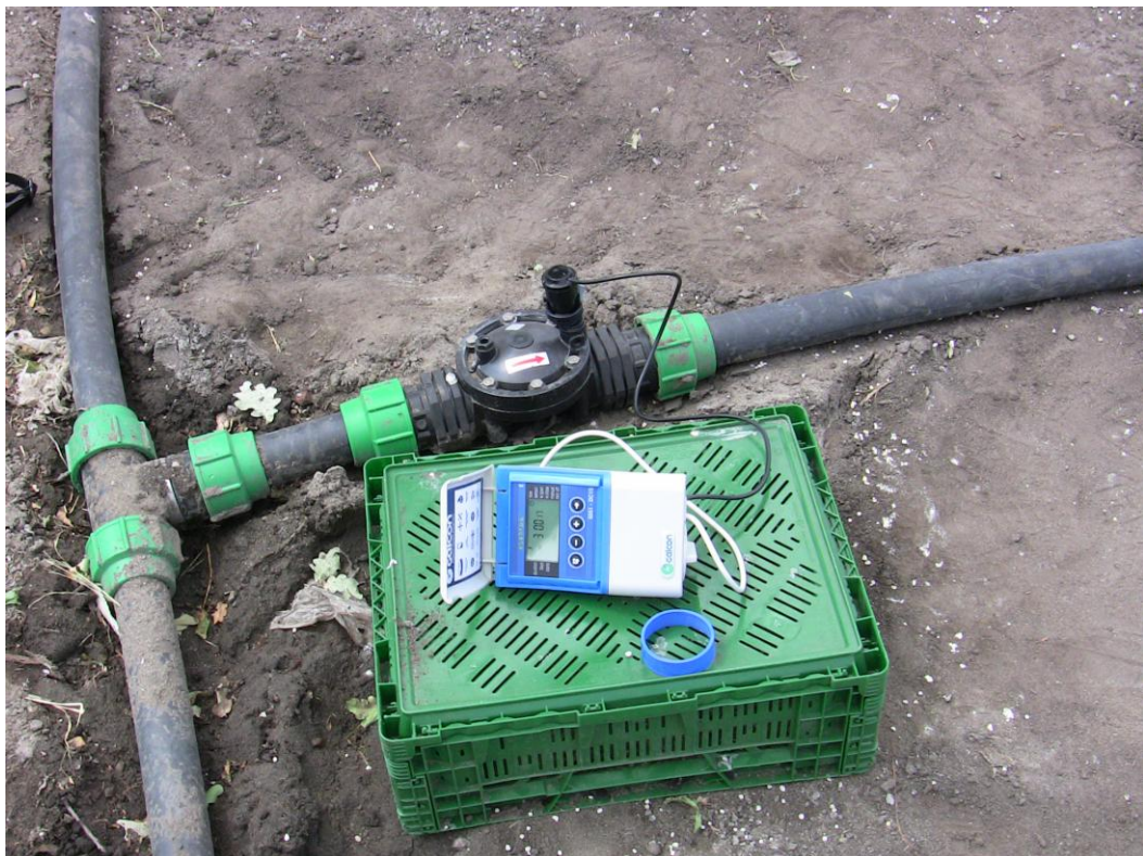
Abbildung 2: Magnetventil mit Steuercomputer [1]
