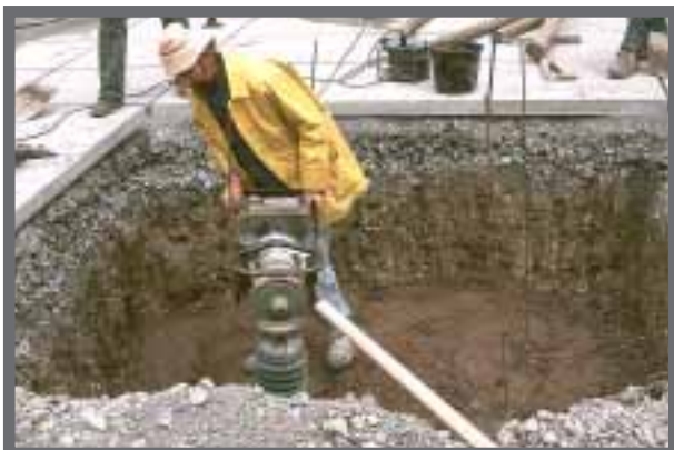
Bild 6: Lageweiser Einbau des verdichtbaren Substrats aus Lava und Sand in der Baumgrube.
