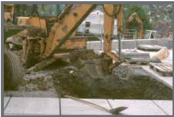
Bild 4: Aushub einer Baumgrube in einer großen, mit großformatigen Betonplatten befestigten Fläche.
