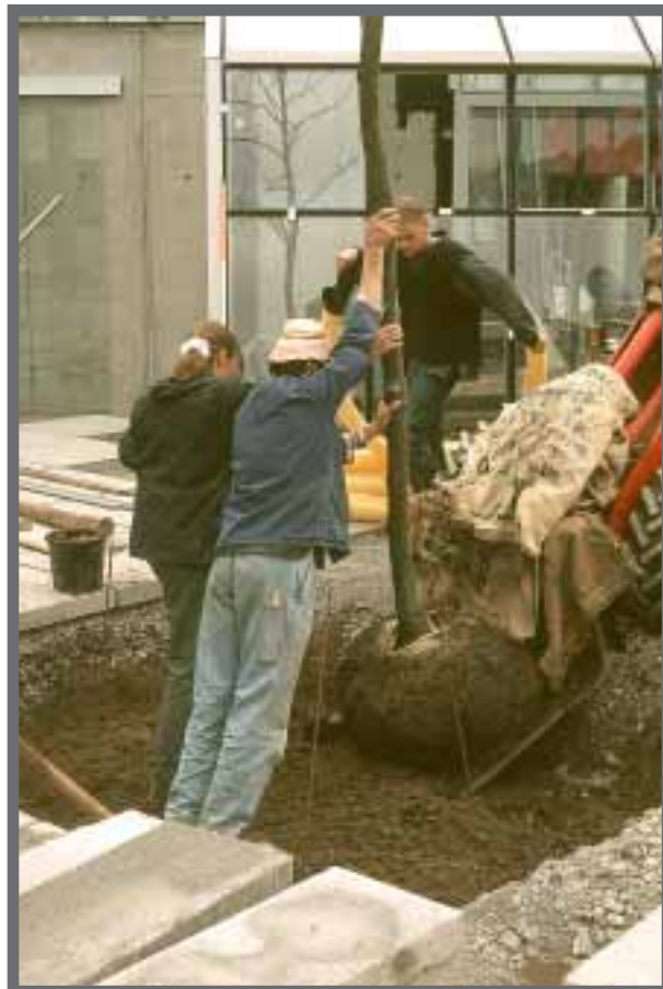
Bild 7: Pflanzung einer Gleditschie in das verdichtete Substrat.
