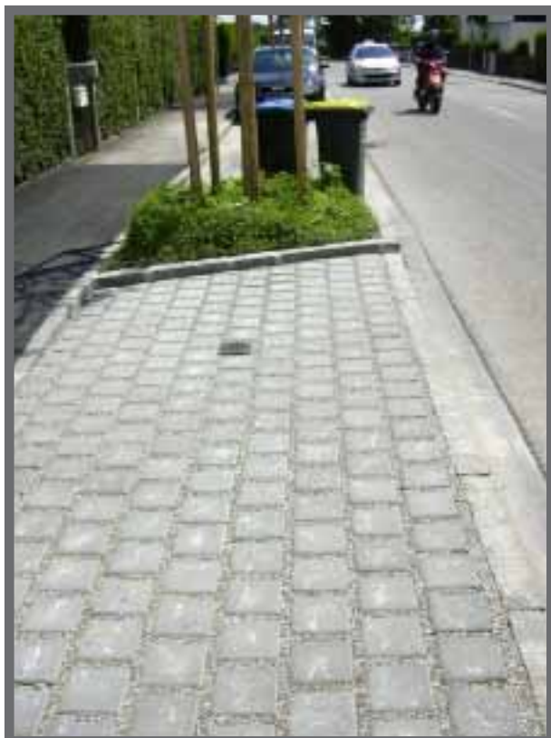
Bild 2: Das Pflaster mit den breiten Fugen stellt den notwendigen Wasser- und Luftaustausch sicher.
