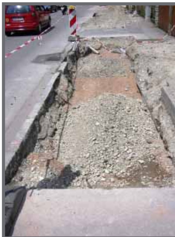
Bild 1: Zur Erweiterung des Wurzelraums wurde die Fläche der Parkstreifen mit verdichtungsfähigem Substrat verfüllt. Durch die Verwendung von Ziegelsand ist es rötlich gefärbt.
