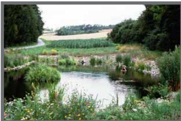
Bild 4: Ein Schönungsteich, nachgeschaltet an eine Pflanzenkläranlage, dient der weiteren Reinigung des gereinigten Abwassers, so dass das hier gesammelte Abwasser als Brauchwasser genutzt werden kann.
