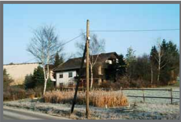
Bild 3: Auch im Winterhalbjahr prägt eine Pflanzenkläranlage das Landschaftsbild positiv, sofern die alten Schilfstängel – denen zugleich eine Frostschutzfunktion zukommt – bis zum Frühjahr belassen werden.
