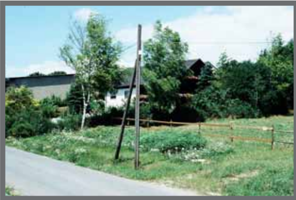
Bild 2: Diese Pflanzenkläranlage wurde zwischen Pferdekoppel und Zufahrtsstraße eingebettet. Sie fügt sich gut in das Landschaftsbild ein und stört in keinsten Weise.
