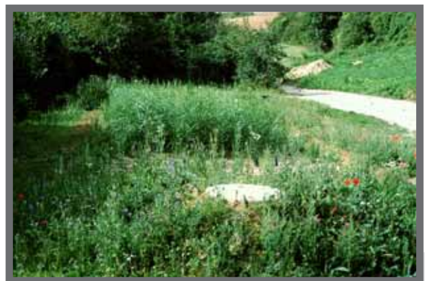
Bild 1: Pflanzenkläranlage mit Zulaufschacht im Vordergrund.
