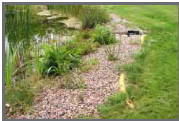
Bild 3: Unsachgemäß eingebaute Abtrennungshilfen werden sehr schnell beschädigt und ihren Aufgaben nicht mehr gerecht.
