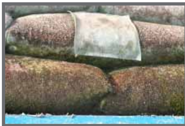
Bild 4: Bereits nach wenigen Jahren müssen die Säcke geflickt oder ausgetauscht werden.
