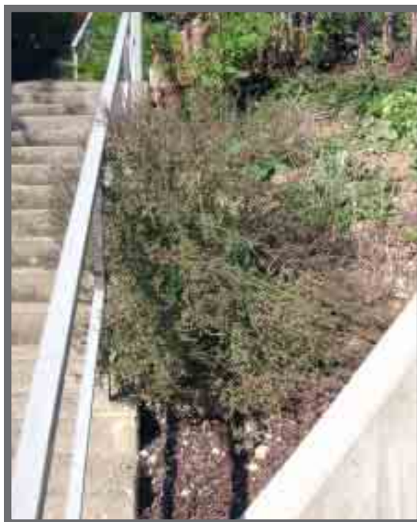
Bild 6: Besiedlung neben der Treppe in einer Wohnanlage.
