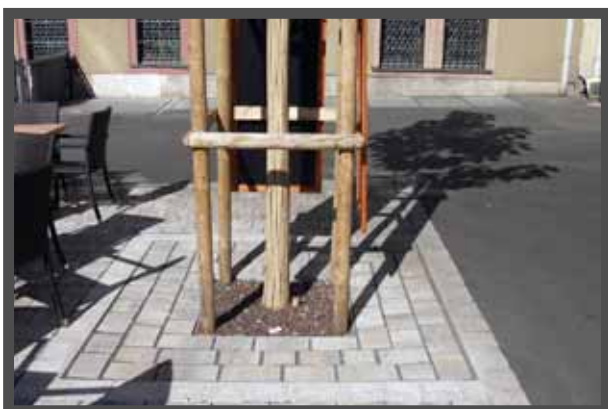
Bild 4: Verdichtbare Substrate in Zusammenhang mit wasserdurchlässigem Pflaster erlauben das Überpflastern der Baumscheibe.
