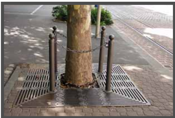
Bild 2: Baumroste schützen das Substrat vor der Verdichtung durch das Belaufen oder Befahren.
