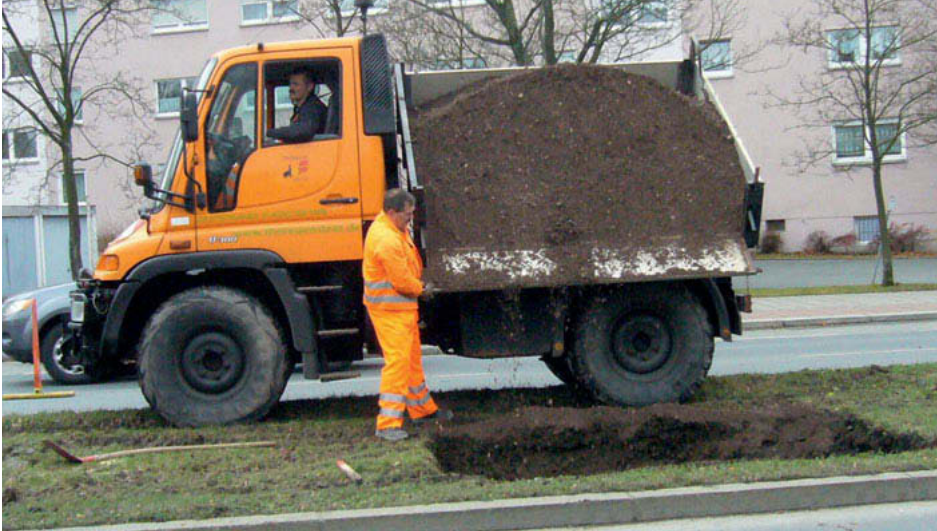
Bild 1: Verfüllung der Baumgrube mit Baums substrat in Hof.
