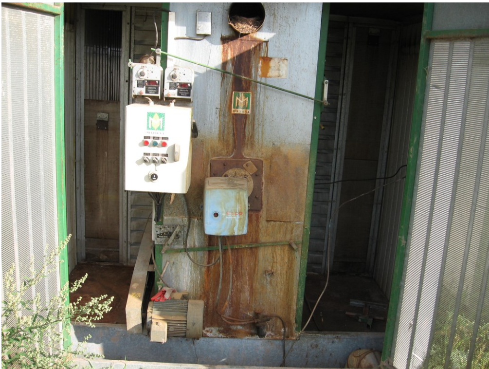
Abbildung 4: Brennerraum (ehemalige Tabaktrocknung) umgebaut zur Nusstrocknung
