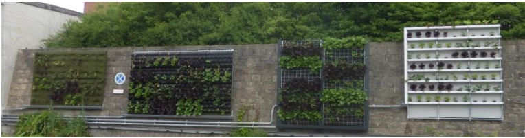
Bild: Living Walls Systeme mit Gemüsepflanzen 24 Tage nach der Pflanzung
