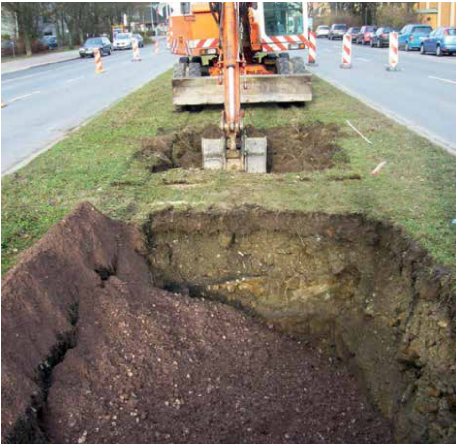
Bild 1: Die Baumsubstrate nach FLL und ZTV-Vegtra-Mü sind einschichtig aufgebaut. Das erleichtert u.a. den Einbau.
