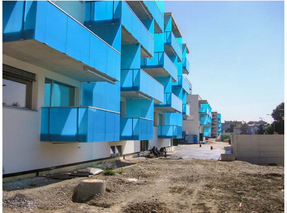
Bild 2: Bei Streitigkeiten über Leistungsänderung kam es oft zum Baustopp; dies soll nun durch ausführliche Regelungen seltener passieren.
