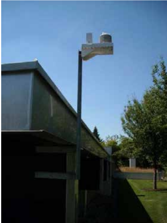
Abbildung 6: ET-Station der Firma Hunter am Technikzentrum (Parzellen 19-23)
