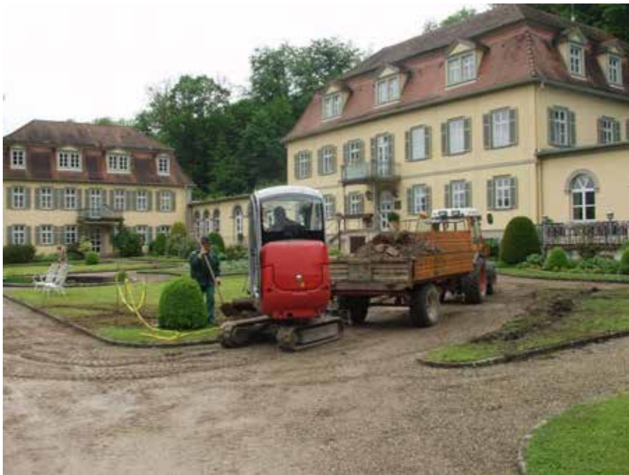
Abbildung 25: Sauberes Arbeiten während des Kurbetriebes, hier am Fürstenhof, wurde vom Unternehmen gefordert und erfüllt. Die nassen Witterungsbedingungen behinderten den Baufortschritt.
