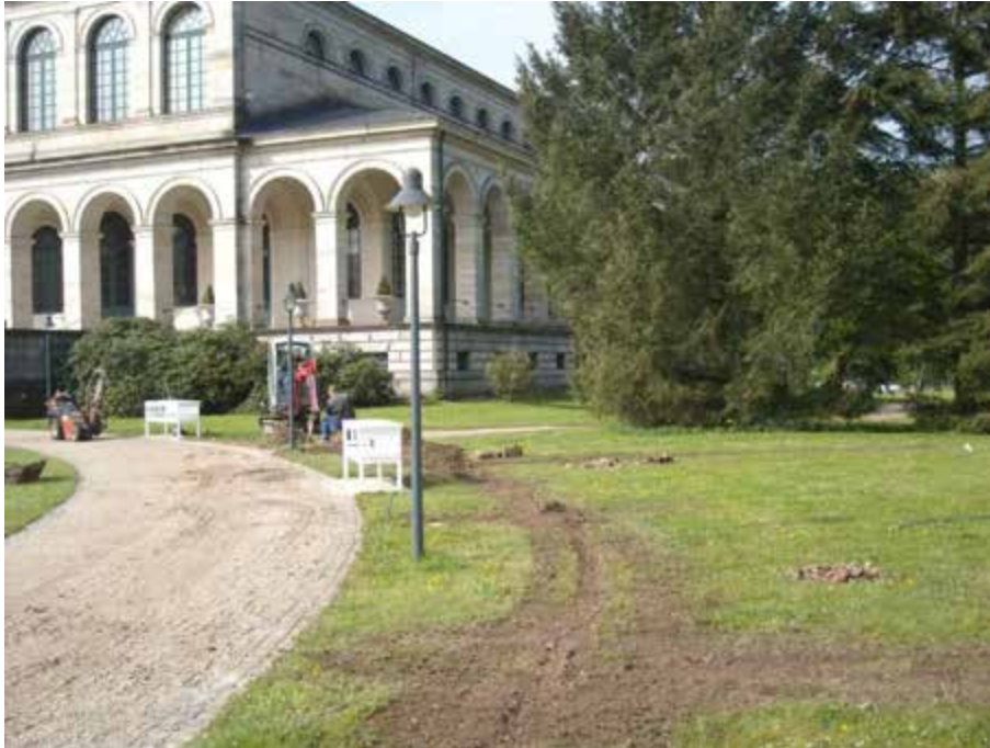
Abbildung 24: Einbau der Rohrleitung mit den Stichen zu den einzelnen Drehstrahlregnern. Im Bild: Steinhäufen, die einen Nachtrag zu den Erdarbeiten rechtfertigen.
