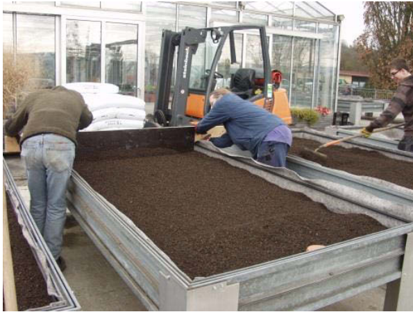
Bild 11: Befüllen und Einebnen des Dachsubstrats auf einem Dachmodell
