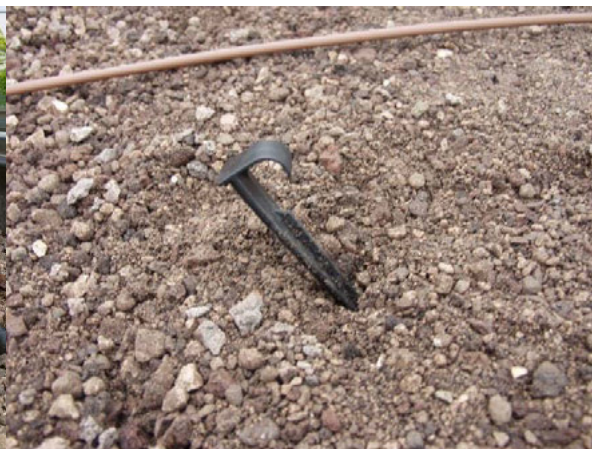
Bild 23: Befestigungshaken für Tropfschläuche im Dachsubstrat
