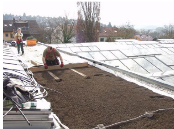
Bild 54: Ausbringung und Einebnung des neuen Dachsub-strats
