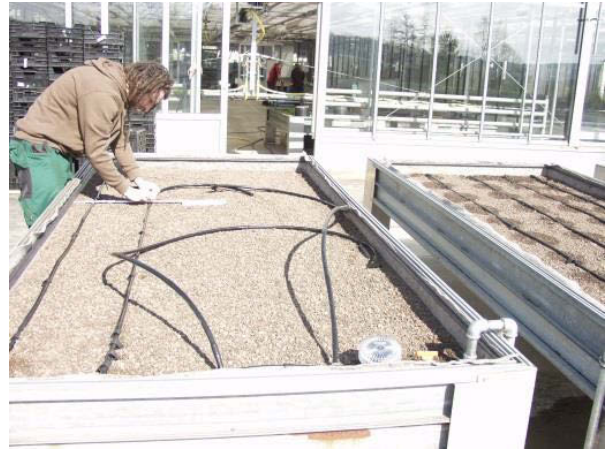
Bild 12: Installation von Tropfschläuchen auf dem Dachsubstrat
