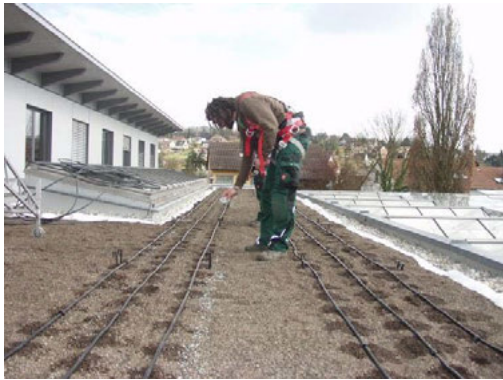
Bild 55: Düngerausbringung auf dem Versuchsdach (nach Ausbringung der Bewässerungseinrichtung)
