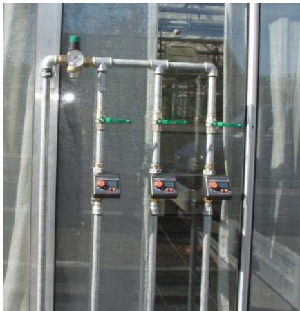
Bild 13: Bewässerungstation mit Bewässerungscomputer und Druckminderer für drei Varianten
