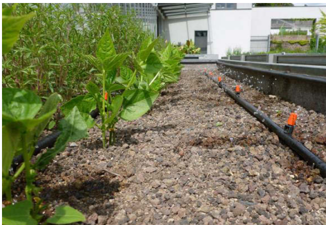
Bild 22: Mikrosprinkler auf einem Dachmodell bei der Bewässerung von Buschbohnen
