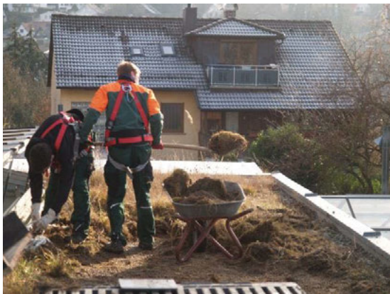
Bild 53: Abräumen der Vegetationsschicht des Versuchs-dachs
