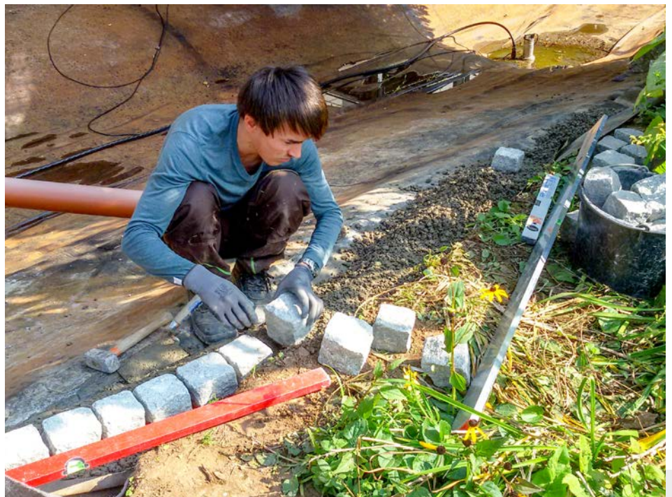
Bild 2: Schutz von Gewässerabdichtungen ist nicht nur für den Bau und Betrieb erforderlich, sondern auch bei Wartung und Pflege – Deshalb ist im neuen Regelwerk dazu ein eigenes Kapitel vorgesehen.
