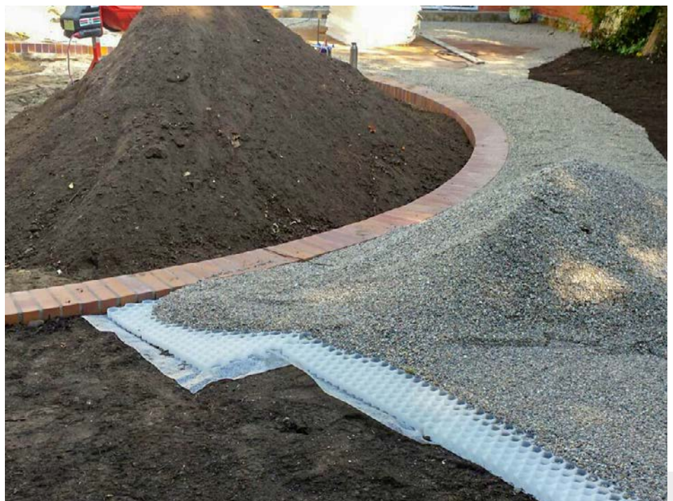
Bild 1: Ein ebener, tragfähiger und wasserdurchlässiger Untergrund reicht zum Verlegen der Waben.
