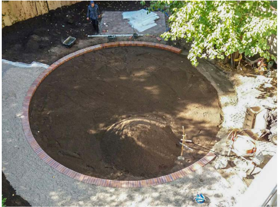
Bild 2: Blick auf die Baustelle – Vorbereitung der Rasenfläche.
