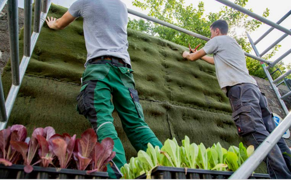
Bild 4: Ein Gerüst erleichtert die Ernte-, Pflege- und Pflanzarbeiten bei Living Walls und bietet zudem ausreichend Schutz vor Abstürzen.
