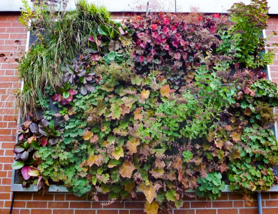
Bild 1: "Living Walls", wie das 2013 für die Versuchsanlage in Nürnberg installierte System von "Optigrün" (Aufnahme vom Oktober 2016), bereichern seit mehr als 10 Jahren das Begrünungsangebot.
