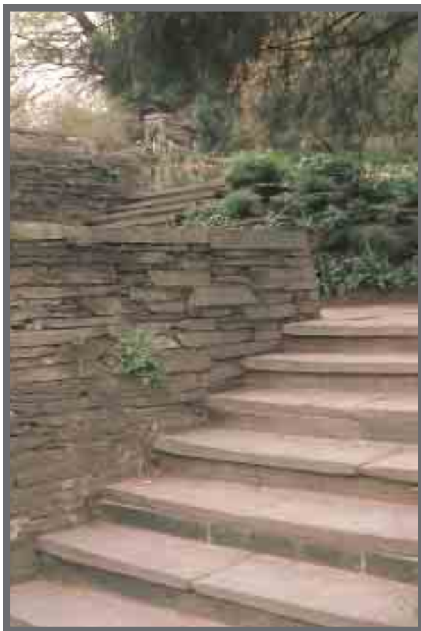
Bild 3: Die Fugen zwischen Legstufe und Setzstein ermöglichen ein interessantes Spiel mit Licht und Schatten.
