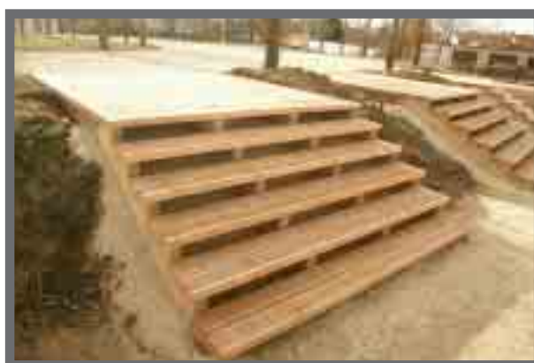
Bild 2: Holzstufen können eine preiswerte Alternative darstellen. Zur Vermeidung der Rutschgefahr bei Feuchtigkeit sind die Bohlen mit Rillen versehen.
