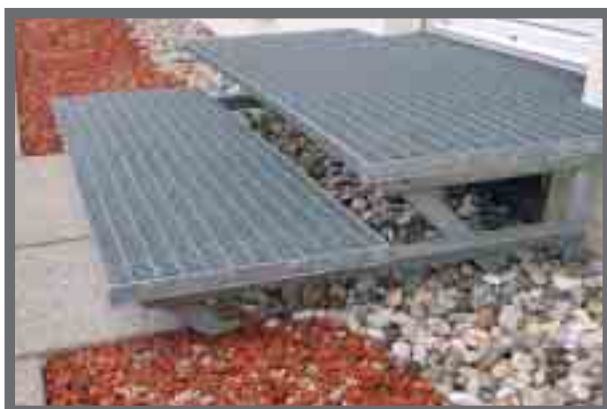
Bild 4: Das Gitter aus verzinktem Stahl wirkt unauffällig und leicht, birgt allerdings eine Gefahr für den Stöckelschuh.
