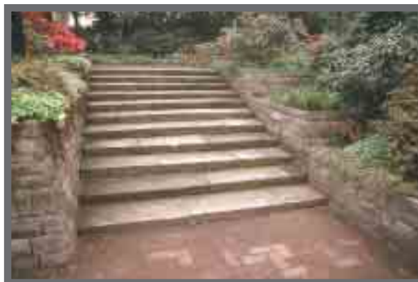
Bild 1: Durch die abgestufte Treppenwange ist diese Anlage harmonisch ins Gelände eingebunden.
