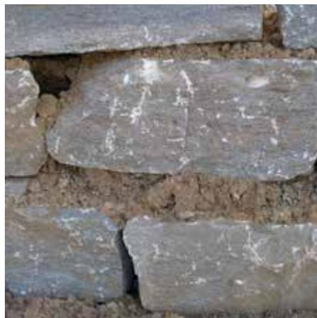
Bild 4: Mit Boden verfüllte Lagerfugen führen zu einer erheblichen Beeinträchtigung der Standfestigkeit.
