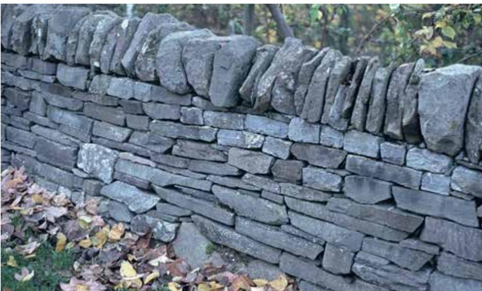
Bild 10: Bei Einfriedungs- oder Grenzmauern besteht die Mauerkrone oft aus einer Rollschicht.
