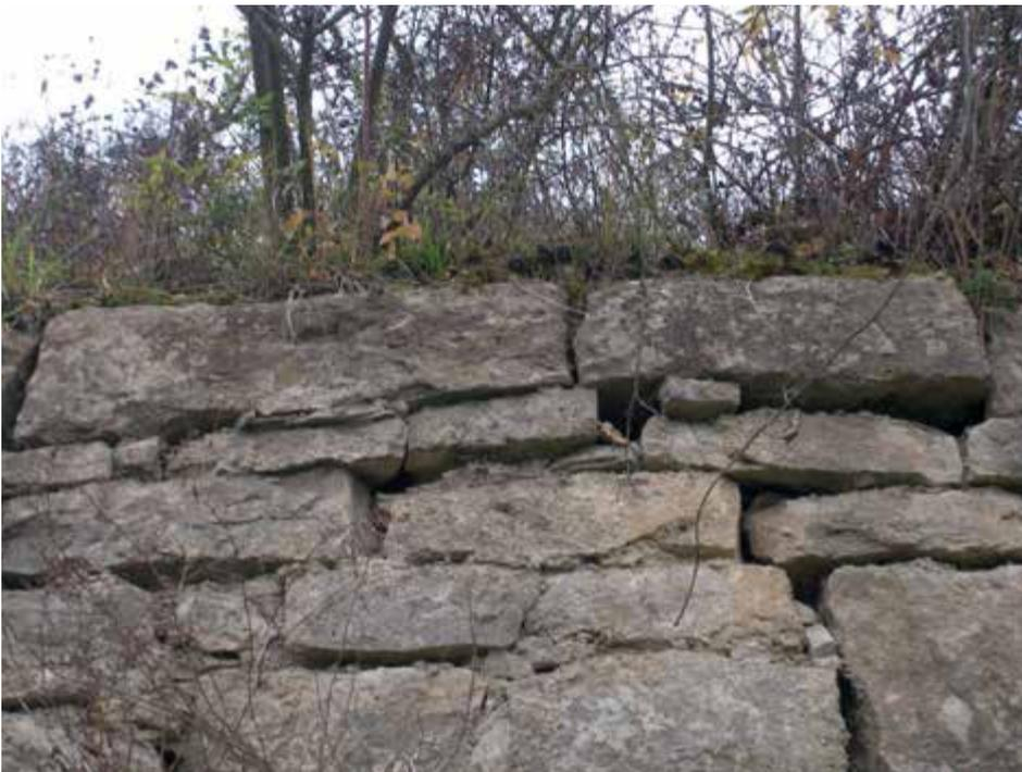
Bild 9: Oberer Mauerabschluss durch „starke letzte Schicht“.
