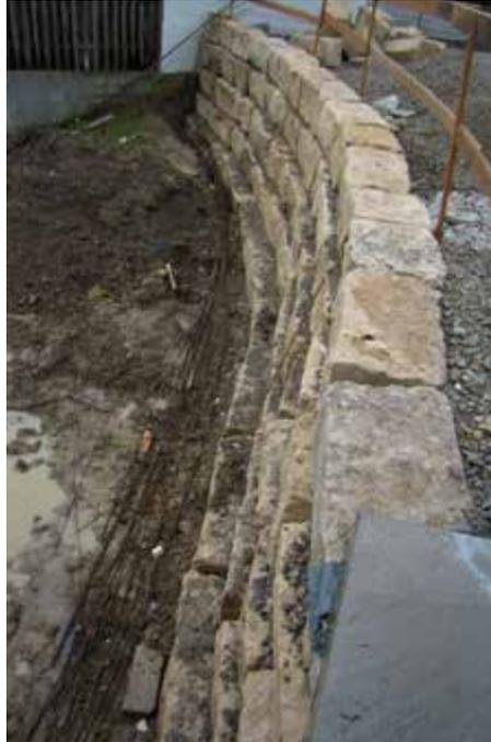
Bild 8: Anlauf durch Zurückversetzen der Steine findet man häufig bei Blockschichtungen.
