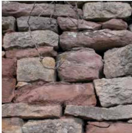
Bild 2: Kreuzfugen, durchlaufende Stoßfugen und mangelnde Überbindung sind häufige Fehler.
