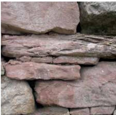
Bild 3: Mauersteine dürfen nicht verwittert sein und keine Risse aufweisen.
