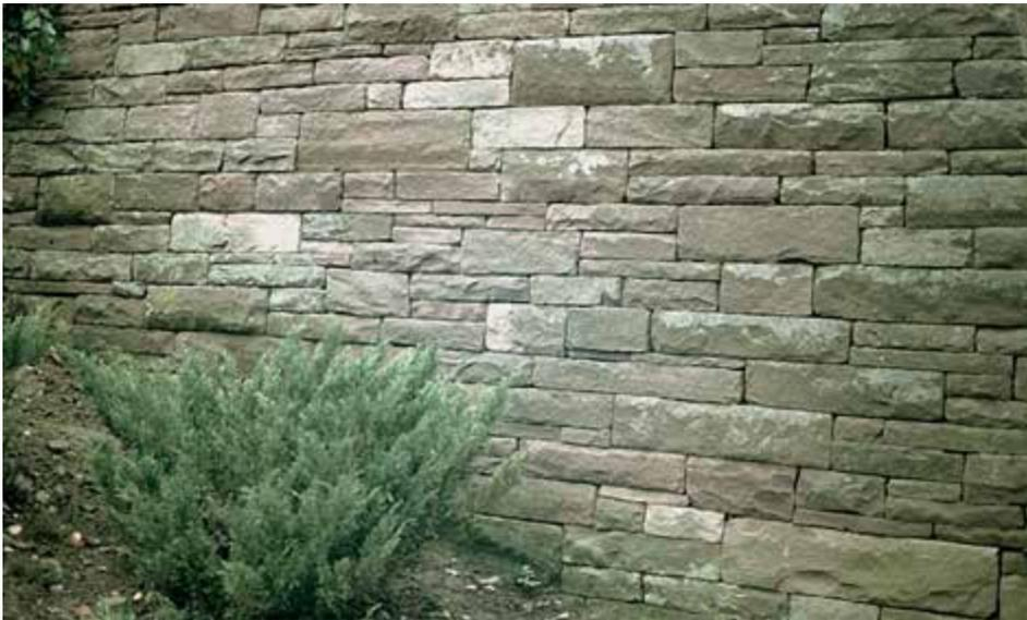
Bild 5: Fachgerecht hergestellte Trockenmauer aus Buntsandstein – dauerhaft und schön.
