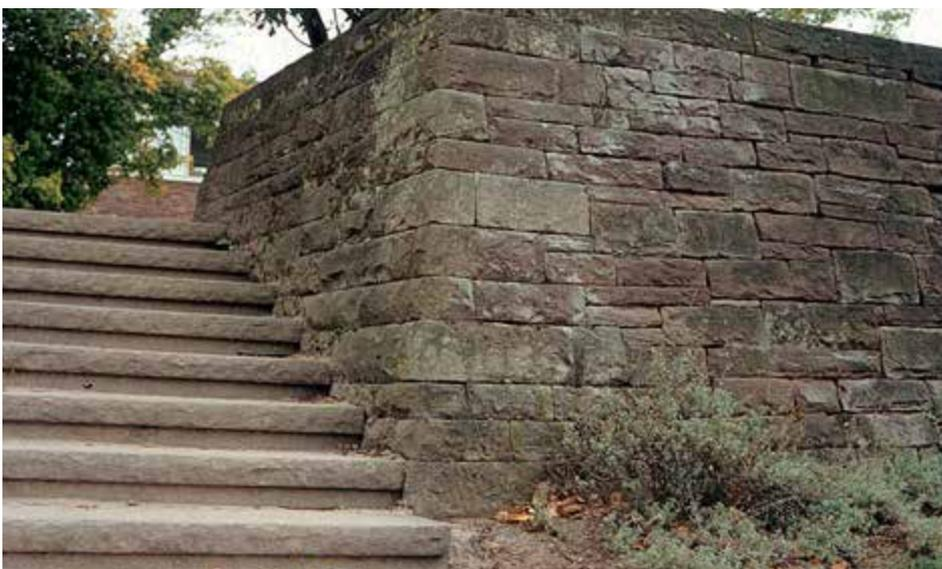
Bild 6: Anlauf sowie Eckausbildung und Mauerabschluss mit großformatigen Steinen erhöhen die Stabilität einer Trockenmauer.
