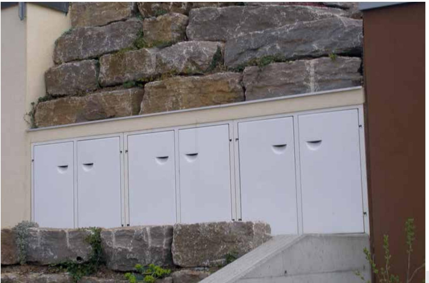
Bild 12: Eine gewagte Kombination aus Natursteinblöcken, Sichtbeton, verputztem Mauerwerk und Betonfertigteilen – alles andere als harmonisch.
