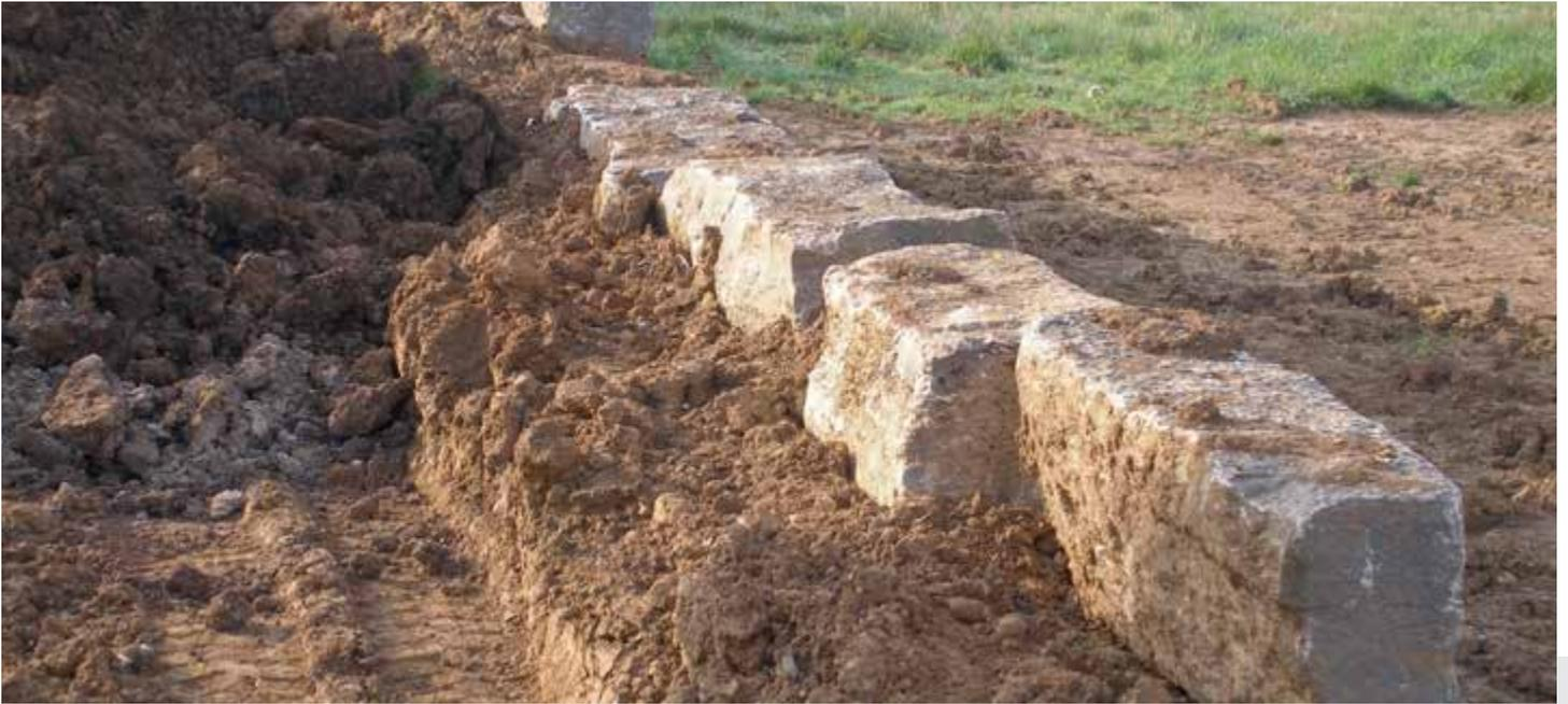
Bild 11: Hinterfüllung mit bindigen Böden kann die Standfestigkeit gefährden.
