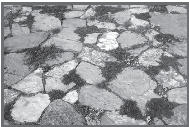
Bild 4: „Fugengärtner“ – Wer solche begrünte Fugen herstellen will, muss mit Nutzungseinschränkungen rechnen.
