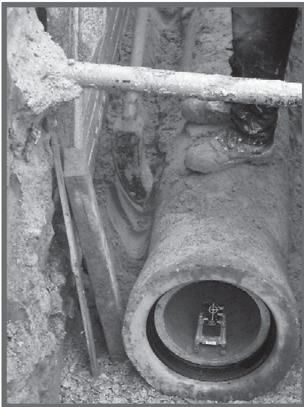
Bild 1: Die Verdichtung der Bettung im Bereich der Rohrzwickel ist schwierig. ...
