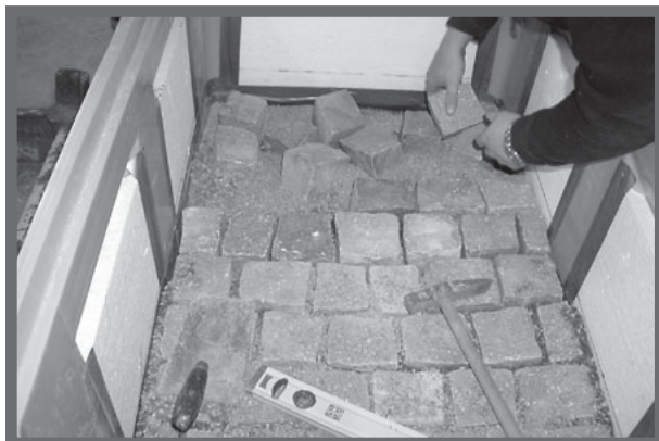
Bild 2: Einbau eines Pflasterbelags in den Prüfbehälter.
