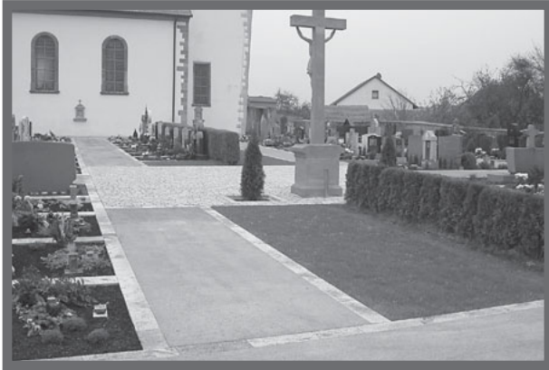
Bild 2: Die Drainbetontragdeckschicht eignet sich gut für repräsentative Zwecke. Eine Randeinfassung ist ästhetisch und statisch sinnvoll. (Foto: Roland Müller)
