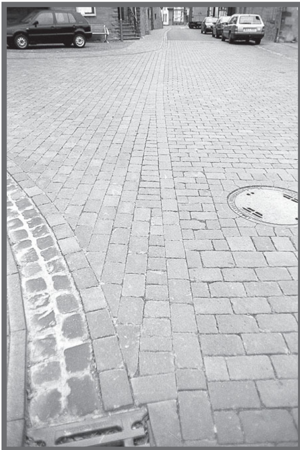
Bild 2: Vorbildlich gepflasterte Anschlüsse im Bereich einer Straßenmündung.
