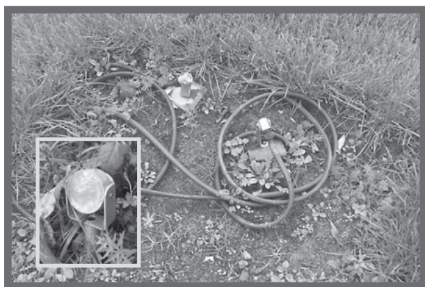
Bild 2: Strahler aus Edelstahl (IP 68), schwenkbar mit Linse.
