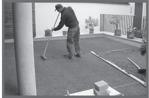
Bild 3: Kleine und kleinteilige Flächen sind für den Einsatz eines Fertigers nicht geeignet, ein Einbau von Hand ist vorzuziehen. (Foto: Roland Müller)
