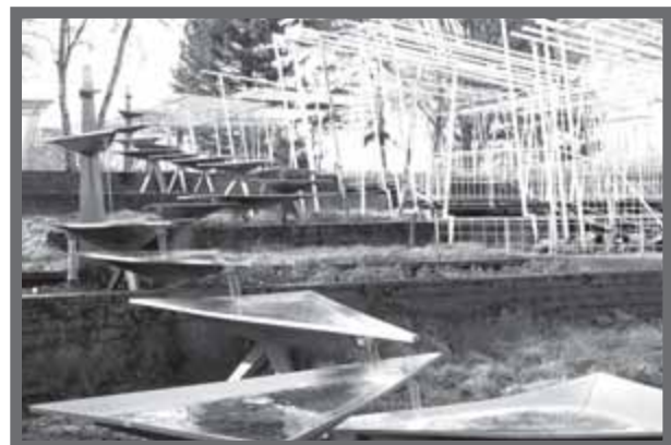
Bild 7: Wassergefüllte Aluminium-Schütten über bepflanzte Betonbecken; im Hintergrund filigrane Stahlpergola.
