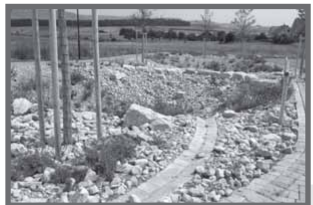
Bild 2: Überlaufmulden Nr. 5 und 6 mit inselartiger Bepflanzung.
