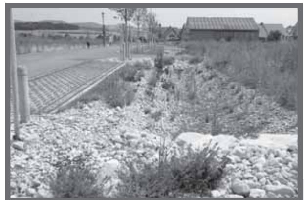
Bild 1: Blick auf die Versickerungsmulden im Baugebiet.
