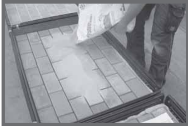
Bild 3: Aufbringen des Fugensandes (hier: Palette 2 mit Dorfner Fugensand+).
