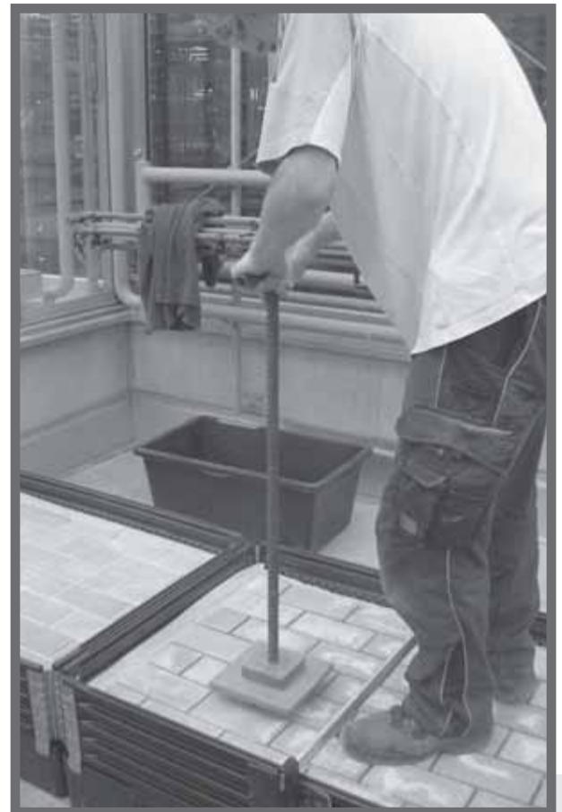
Bild 4: Verdichten der verfugten Pflasterflächen mit einem Handstampfer.
