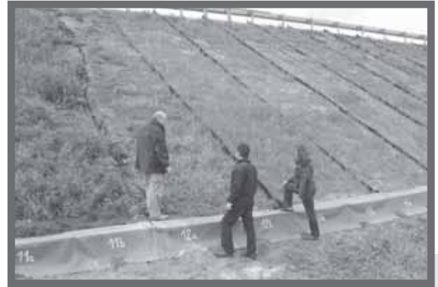
Bild 3: Steil, steiler, grün? 8 verschiedene Erosionsschutzsysteme im Praxistest an der Autobahn A 3, Anschlussstelle Rottendorf.
