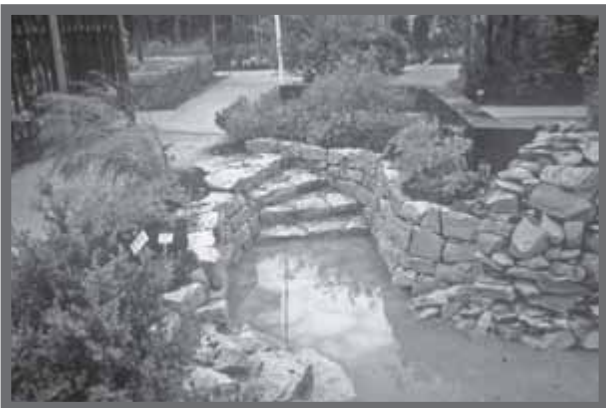
Bild 2: Die Auswahl präqualifizierter GaLaBau-Unternehmen verringert das Risiko von Baumängeln wie dieser mangelhaften Entwässerung.
