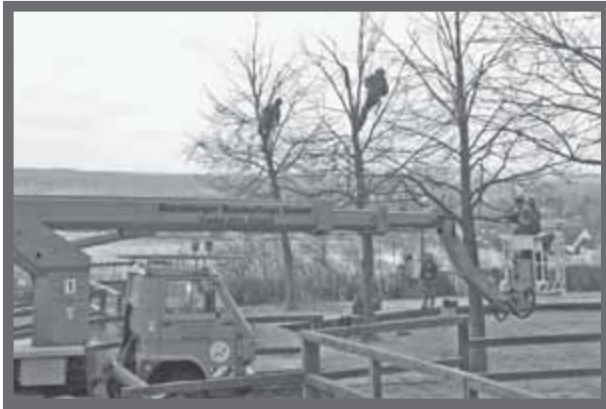
Bild 4: Baumpfleger am Werk; ob unter Einsatz der Seilklettertechnik oder des Hubsteigers, Baumpflege ist Arbeit für Profis!
