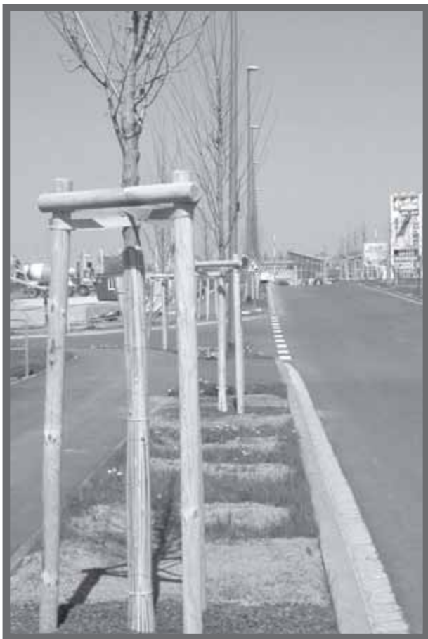
Bild 7: Die Dreipfahlverankerung bei dieser groß angelegten Baumpflanzung in Würzburg wurde vorbildlich durchgeführt. Die Angebotspreise schwankten zwischen 38 und 45 €.
