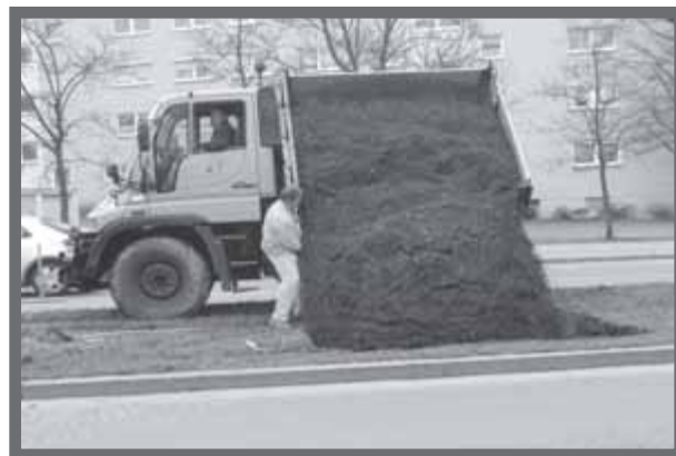
Bild 1: Verfüllung der Baumgrube mit Baumsubstrat in Hof. (Bild: S. Böll)
