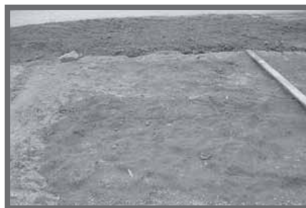
Bild 3: Boden unter Sechseckwabenplatten
