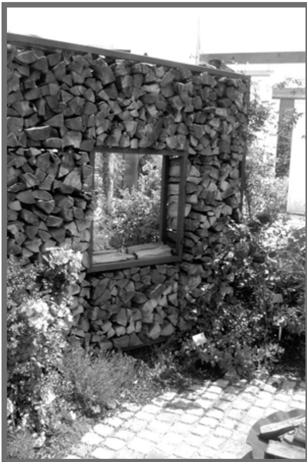
Bild 4: Das „Gartenfenster“ aus einer mit Kaminholz gefüllten Eisenkonstruktion erlaubt spannende Einblicke in den Garten.
