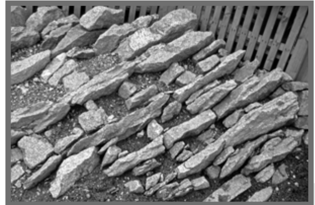
Bild 8: Bau eines Felslehnen-Gartens aus Rhyolith: die in langen Bändern gestellten Platten werden durch dazwischen gelagerte kleinere Steine auf Abstand gehalten und stabilisiert. Diese werden später mit Pflanzsubstrat überfüllt.
