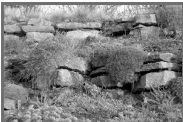
Bild 7: Terrasiert angelegte Trockenmauer-Bänder aus quaderförmigen, bruchrauen Kalksteinen (Oolith) gliedern diese Steinanlage.
