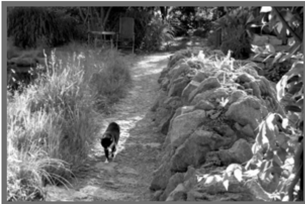
Bild 6: Trockenmauerwall aus Rhyolith-Platten in fast senkrecht gestellter Ausrichtung als Trennung zwischen Teich und einer tiefer liegenden Gartenzone.
