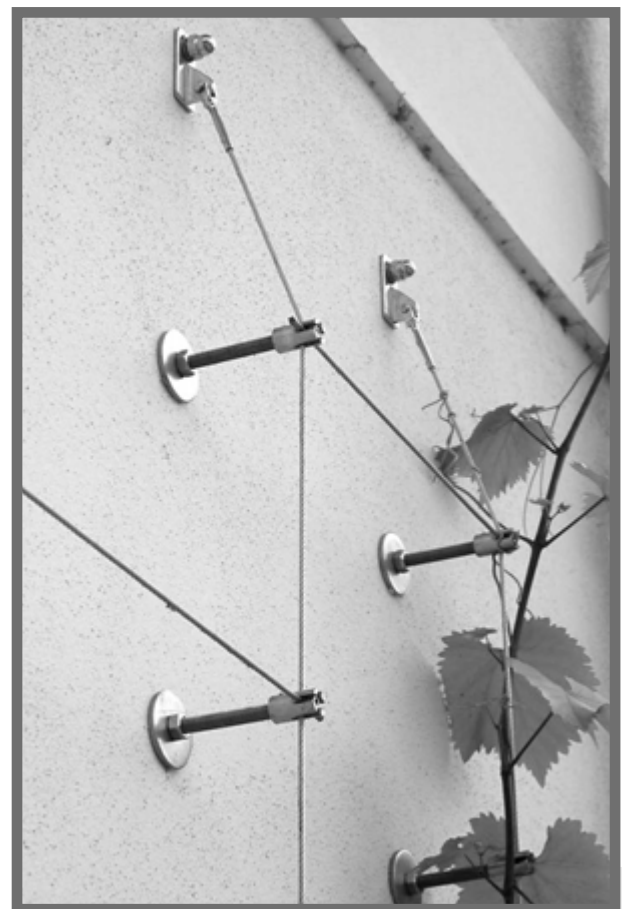
Bild 1: Details einer Seilkonstruktion. Quelle: Archiv Sven Taraba
