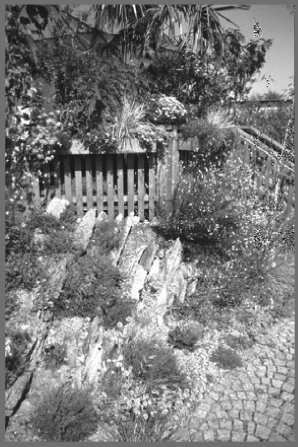
Bild 9: Nach dem Abstreuen der Oberfläche mit Rhyolith-Splitt und Bepflanzung ergibt sich der Eindruck eines natürlichen Felsens, der die Veranda trägt.
