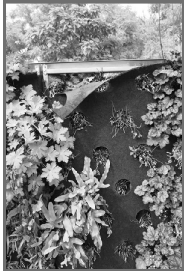
Bild 4: Auch bei der Living Wall in Appellern sind Pflanzenausfälle sichtbar. Zudem löst sich hier schon das Textilmaterial aus dem Trägersystem.
