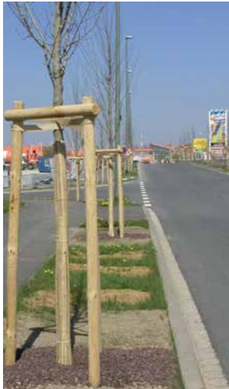
Bild 6: Die Dreipfahlverankerung bei dieser groß angelegten Baumpflanzung in Würzburg wurde vorbildlich durchgeführt. Die Angebotspreise schwankten zwischen 38 und 45 €!!!
