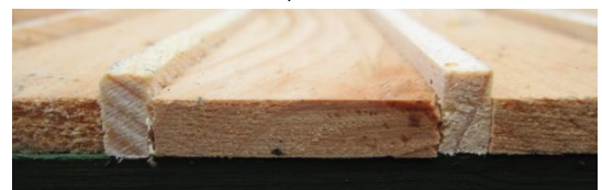
Abbildung 4: Die Zwischenleisten dürfen durchaus über die Oberträger hinweg stehen.
