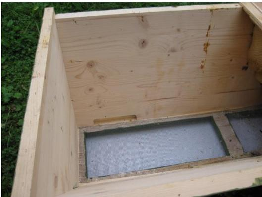
Abbildung 1: Aufgesägter Boden mit von innen aufgetackertem Drahtgewebe (Draufsicht, linkes Abteil).
