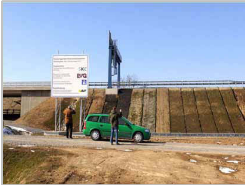
Versuchsböschung bei Biebelried nach erfolgreichem Einbau der Systeme und anschließender Anspritzbegrünung
