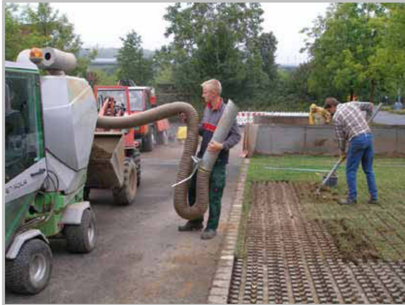
Sanierung des Parkplatzes an der Parkstraße, Veitshöchheim (September 2009)
