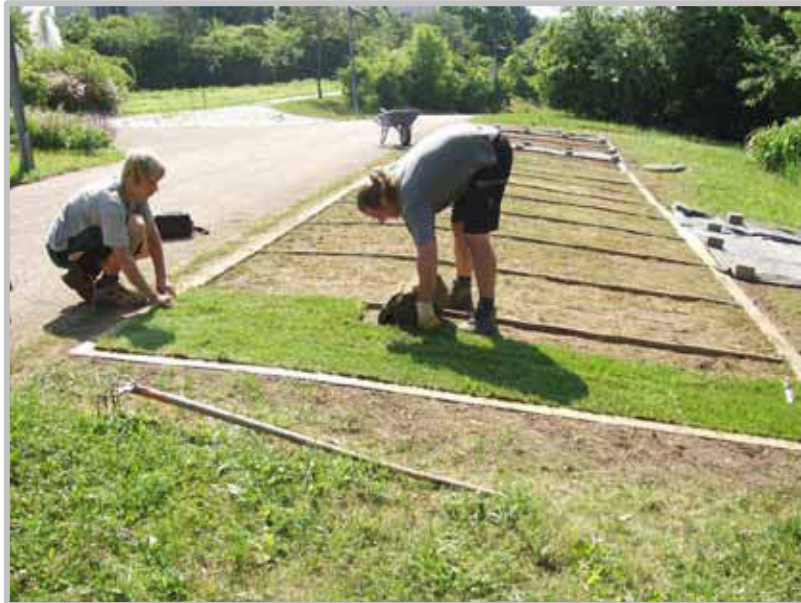
Mitarbeiter des Versuchsbetriebes Landespflege legen Rollrasen über vorhandenen Altrasen
