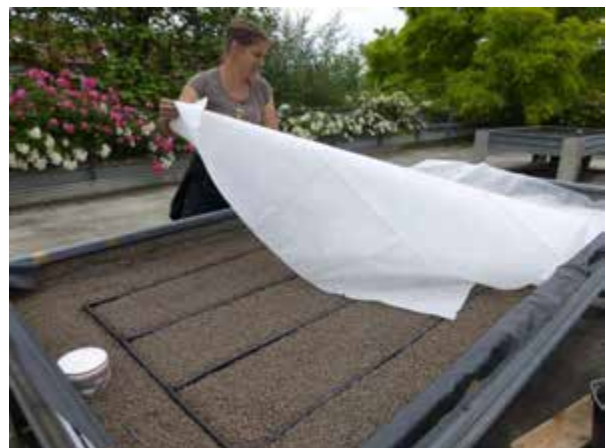
Bild 4: Ausbringung von dünnem Schutzvlies im
