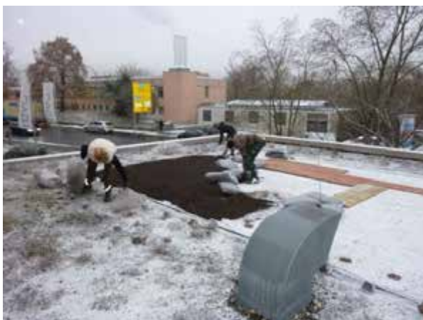
Bild 25: Ausbringen Dachsubstrat auf dem Versuchsdach der LGA
