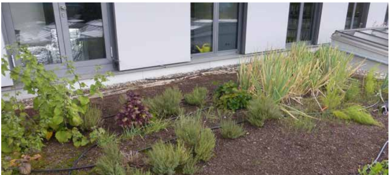
Bild 38: Randbereich auf dem Dach in Veitshöchheim am 20.09.2017
