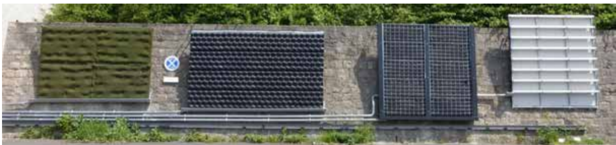
Bild 40: Living Wall System in Veitshöchheim vor der Bepflanzung im Jahr 2011
