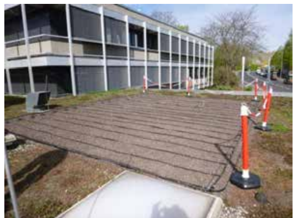
Bild 26: Auslegen der Bewässerung auf dem Versuchsdach der LGA und Absperrkette zur Sicherung
