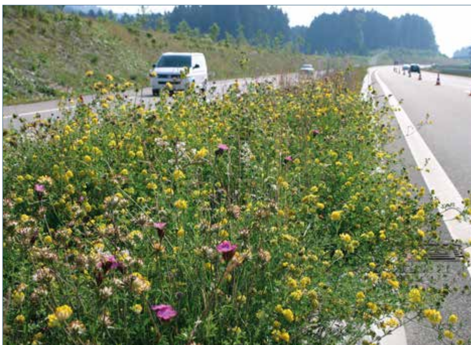
Blühende Betongleitwände an der Autobahn A7 bei Nesselwang, Foto: Kornelia Marzini, Veitshöchheim
