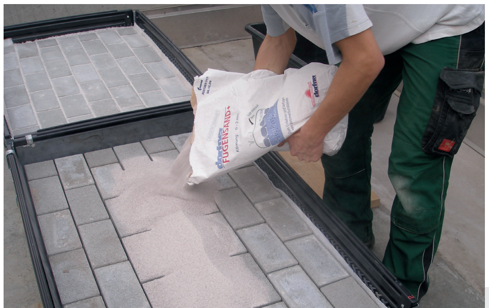
Bild 1: Aufbringen des Fugensandes (Aufnahme 21.01.2010)
