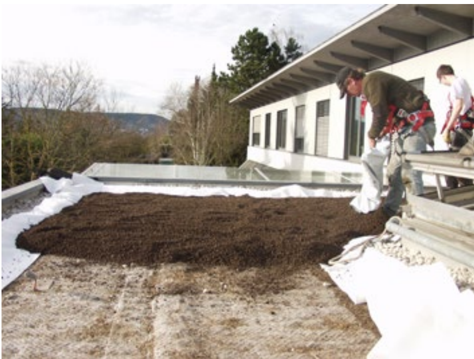
Bild 1: Gemüse auf dem Dach begnügt sich mit dem gleichen Schichtaufbau wie bei einer extensiven Dachbegrünung.
