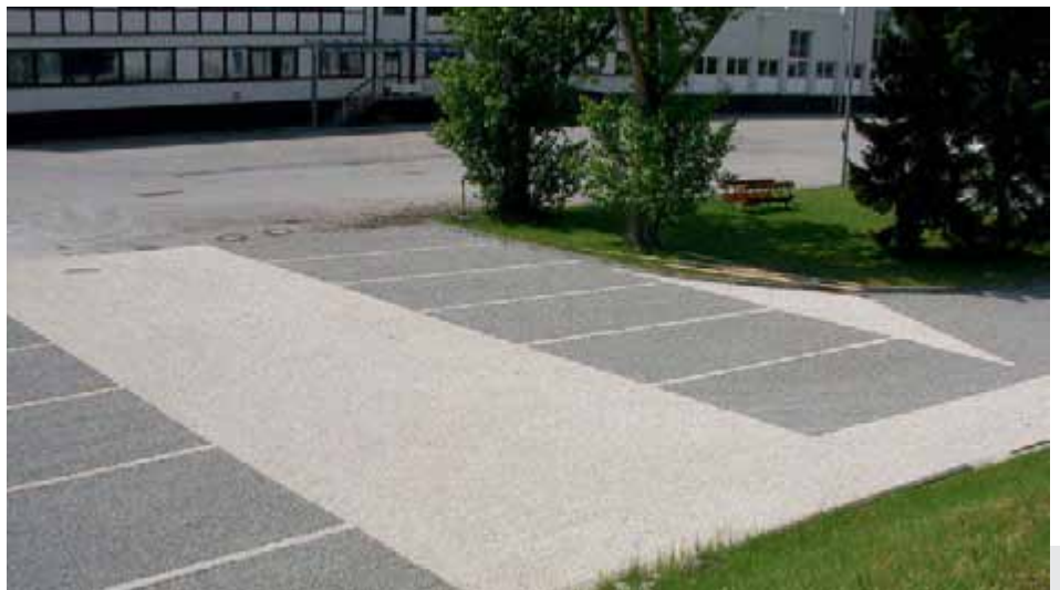
Bild 5: Durch die Füllung der Waben mit unterschiedlich gefärbten Kiesen oder Splitten lassen sich Stellplätze markieren.
