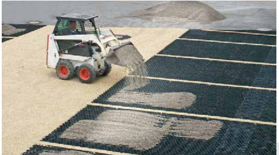
Bild 4: Maschinelles Befüllen der Waben aus Recyclingkunststoff.
