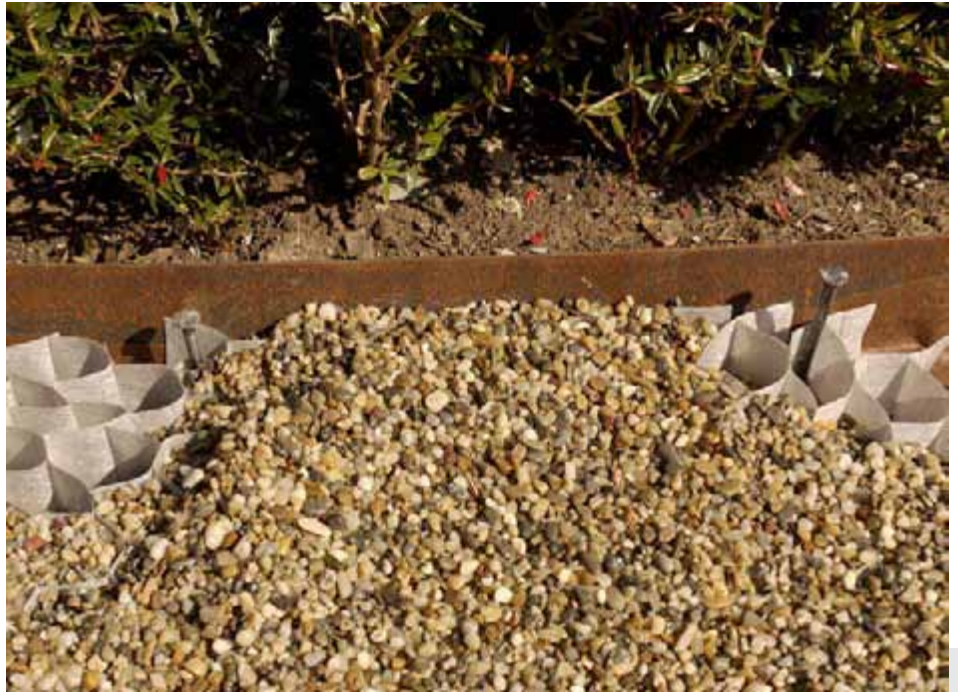
Bild 8: Nach dem Abstreuen mit 2 bis 3 cm Kies sind die Waben nicht mehr sichtbar. Der Rand wird mit Bandstahl eingefasst ...
