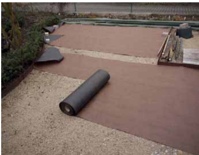
Bild 6: Beim Einbau von Wagengewebe wird auf dem Unterbau oder der Tragschicht zunächst ein Vlies zur Unkrautunterdrückung verlegt ...
