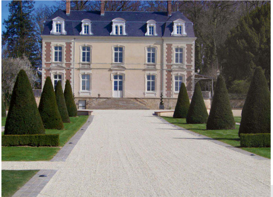
Bild 1: Mit Nidagravel armierte Kiesfläche im Eingangsbereich eines Schlosses.
