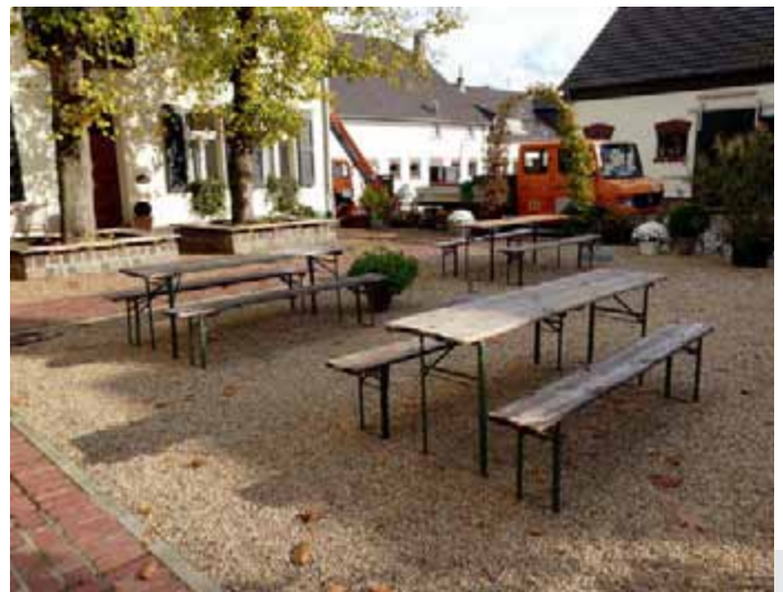
Bild 3: ... und schließlich mit einer 2–3 cm starken Deckschicht aus Feinkies abgestreut werden.
