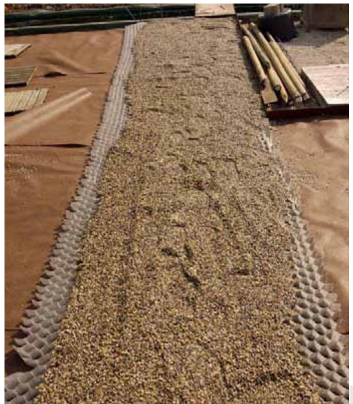
Bild 7: ... die gefalteten Waben-Elemente werden auseinandergezogen, mit Erdnägeln befestigt und mit Kies verfüllt.
