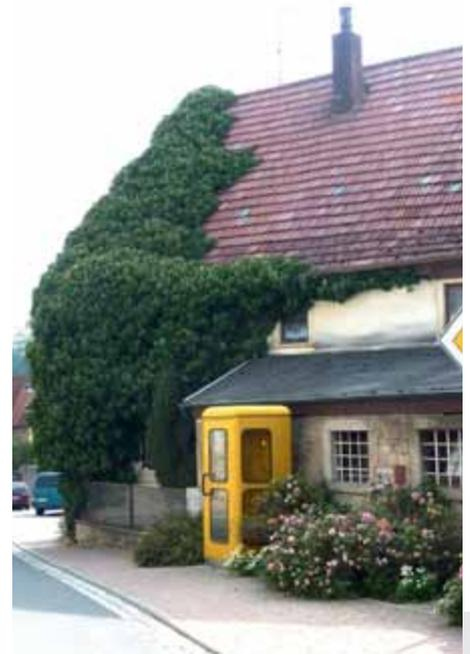
Bild 21: Bei „vergessenem“ Efeu sind Schäden im Dach vorprogrammiert.
