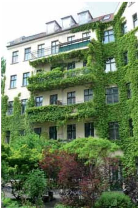
Bild 1: Eine flächige Fassadenbegrünung mit Selbstklimmern, wie hier mit *Parthenocissus*, erfordert regelmäßig aufwändige Pflegegänge.
