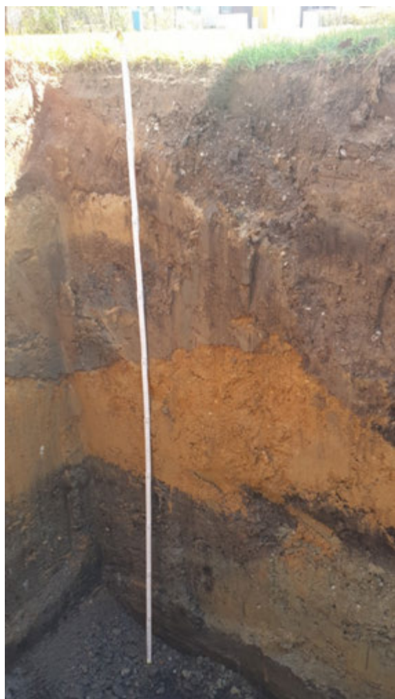
Abbildung 9: Pflanzgrube mit 2m Tiefe (Foto: © Mario Dietrich, Stadt Pfaffenhofen)
