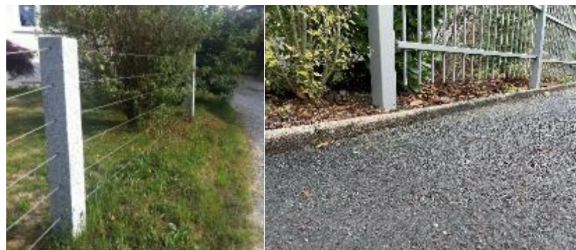
Bild 16 & 17: Spannseil- und Metallstaketenzaun mit flacher Randeinfassung lässt auf voller Länge Raum für Igel, Frosch & Co.
