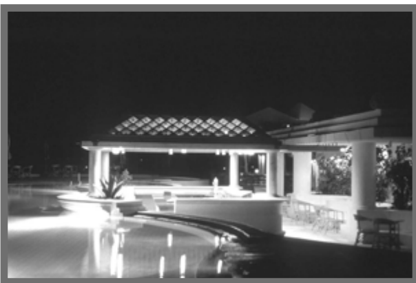
Bild 4: Das eigenwillige Kassettendach wird durch die Beleuchtung in harte Kontraste gesetzt und besonders hervorgehoben. Der warme Holzton setzt sich angenehm vom kühlen Blau des Pools und vom Dunkel der Nacht ab.
