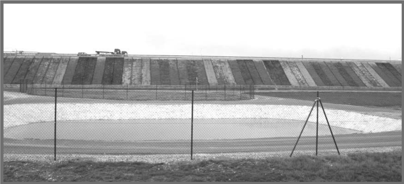
Bild 1: Ansicht der Versuchsanlage im April 2010. Deutlich sind die freien Flächen und inhomogenen Bestandsstrukturen mancher Systeme zu erkennen.
