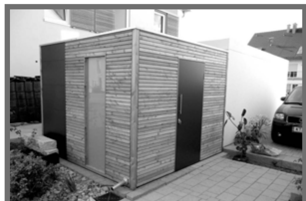
Bild 3: Ein modernes Holzbauwerk. Die Oberfläche strukturiert sich durch das starke Fugenbild. Der kubische Körper wird aufgelöst durch die großflächige Kombination mit Glas und einer beschichteten OSB-Platte.
